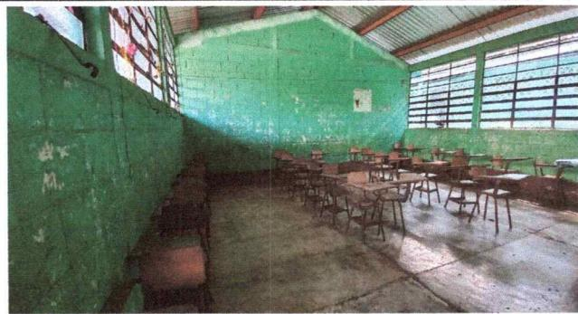
Foto1: Se observa el deterioro y desprendimiento de pinturas en las paredes interior del modulo 1.
