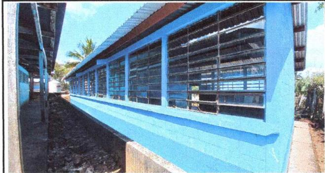
Foto 4: Se observa el area de las ventanas con desprendimientos de vidrios en malas condiciones y/o fantante en las bases en el modulo 1
