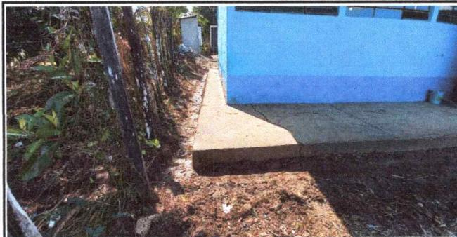
Foto 5: Se observa las cunetas en pesimas condiciones y parte del corredor con hundiciones severas en el modulo 1.
