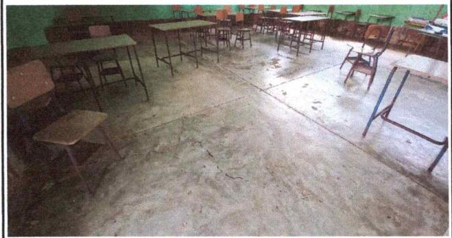
Foto 2: Se observa la humedad del piso deteriorado con grietas y agujeros avanzadas en el modulo 1
